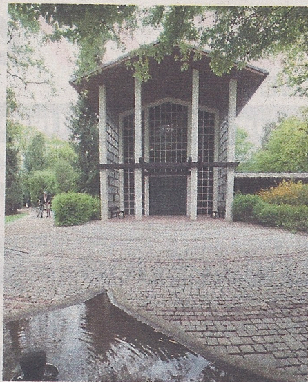
Die Aussegnungshalle in Oberhaching soll saniert werden.
